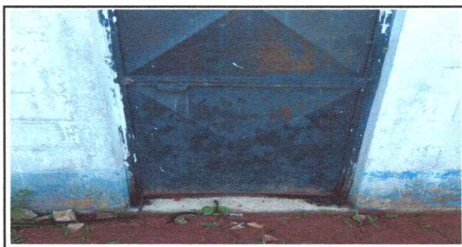
Foto 5: Sustitucion de puertas del modulo 4 en mal estado
