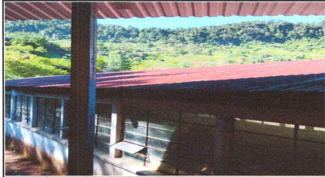
Foto 2: Cambio de entechado por picadura de laminas
